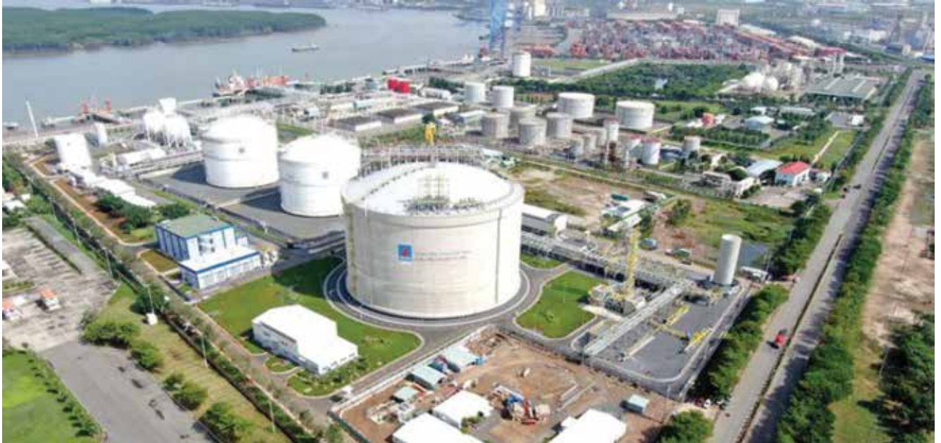
▲ Kho cảng LNG Thị Vải do Tổng Công ty Khí Việt Nam (PV GAS) đầu tư xây dựng tại khu công nghiệp Cái Mép, thị xã Phú Mỹ, tỉnh Bà Rịa - Vũng Tàu
